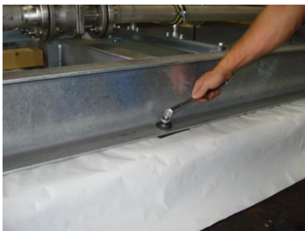
Verschrauben einer Pumpe / Screwing a pump
